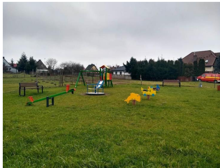
Budowa placu zabaw na działce 414/9 w Chociwlu
