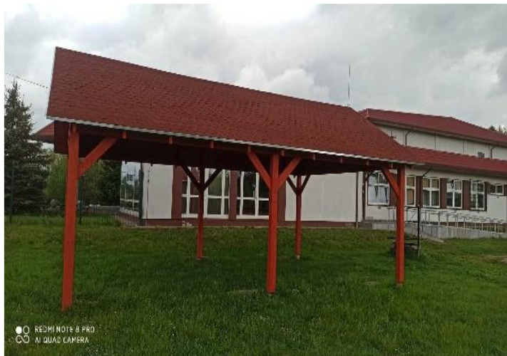
Altana ogrodowa przy hali widowiskowo – sportowej w Chociwlu
