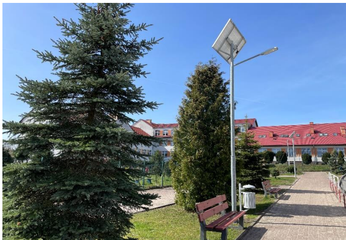
Lampy solarne przy Hali Widowiskowo-Sportowej
