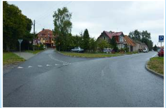
Przebudowa ulicy Dworskiej z 21 miejscami parkingowymi oraz ul. Szkolnej
