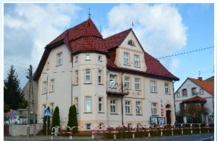
Wykonanie modernizacji budynku Urzędu Miejskiego
