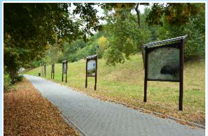
Trwa montaż infrastruktury rekreacyjno-edukacyjnej. Zamontowane zostaną jeszcze ławki, kosze, wiaty
