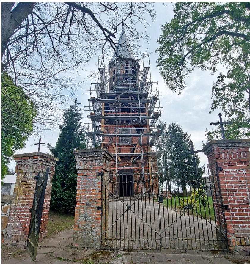
Remont kościoła w Brodzie, fasada zachodnia (fot. z 2025r.)
